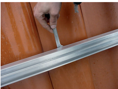
Schiene festschrauben
