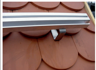
Schiene montiert
