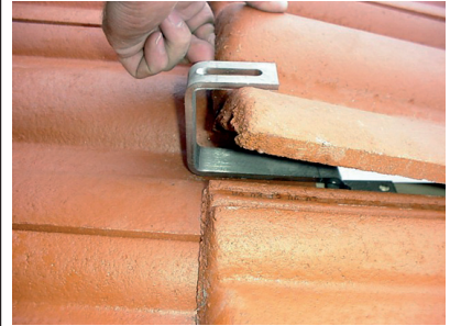
Ziegel einsetzen
